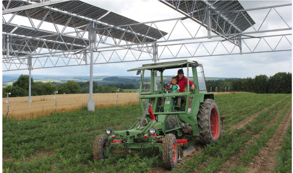
Abbildung 1 und 2: Beispiele für horizontale APV-Systeme mit landwirtschaftlichen Kulturen oben und im Obstbau unten (© Fraunhofer ISE)
