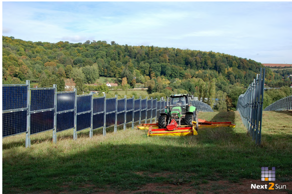
Abbildung 3 und 4: Beispiele für vertikale APV-Systeme in der Grünlandbewirtschaftung (© Next2Sun)
